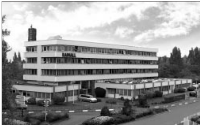
Head Office - Rosny sous Bois
