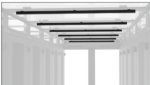
Příklady svítidel instalovaných pod sítěchou chodby
